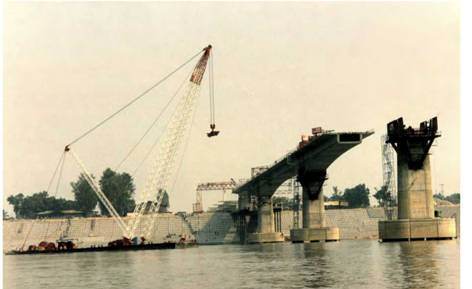
ຂົວໄດ້ຖືກອອກແບບ ແລະ ບໍລິຫານການກໍ່ສ້າງໂດຍອິດສະຕຣາລີ, ໄດ້ຮັບການກໍ່ສ້າງໂດຍຊ່າງກໍ່ສ້າງຄົນລາວ ແລະ ຄົນໄທ ພ້ອມນຳໃຊ້ວັດຖຸກໍ່ສ້າງຈາກລາວ ແລະ ໄທ.
